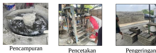
Gambar 1. Dokumentasi pembuatan paving block
