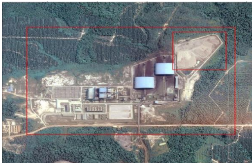
Gambar 1. Kondisi eksisting RTH pada lokasi penelitian
